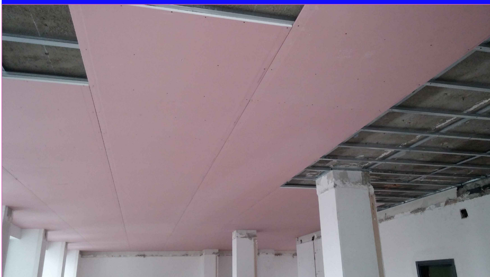
Dettaglio installativo REI 120
