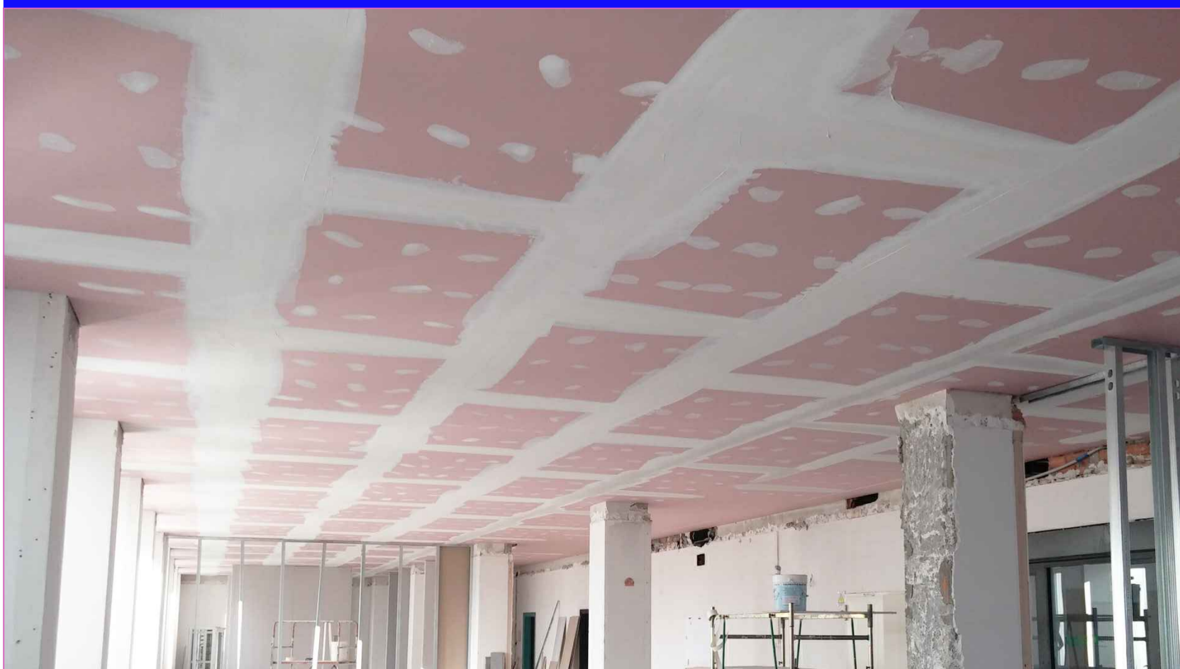
Dettaglio installativo REI 120
